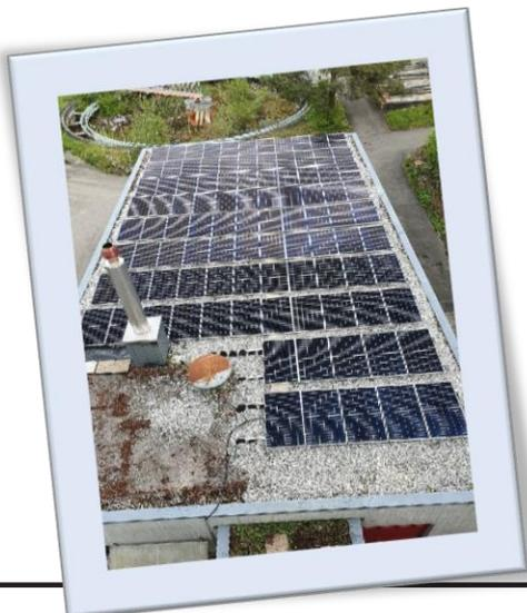
Für dieses Jahr war eine PV-Anlage von 88kWp geplant. Diese wurde auf dem Betriebs- und Maschinengebäude und dem Faulraum installiert. Mit grosser Freude konnte am 3.5.2021 die Anlage bereits in Betrieb genommen werden.
